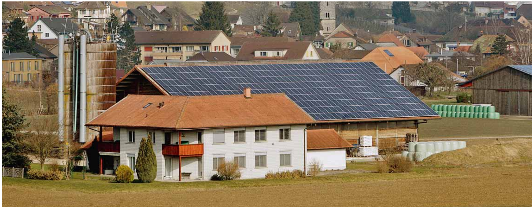
Nur bedingt autark: Bei schlechtem Wetter brauchen auch Betreiber von Photovoltaikanlagen wie dieser Landwirt in Erlach Strom vom Netz. Wie viel sie an dessen Ausbau zahlen sollen, ist strittig. Symbolbild: Olivier Gresset/a
